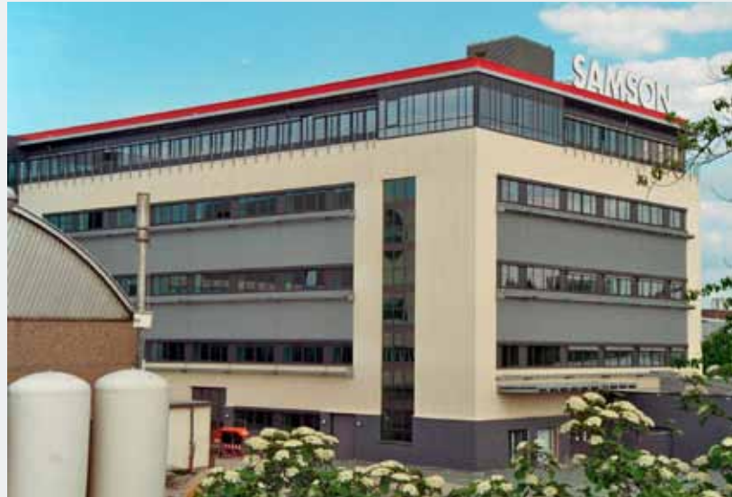
Die neue Produktionshalle ist mit einer Grundfläche von 3150 m 2 und 28 m Höhe eines der größten Gebäude der SAMSON AG.
